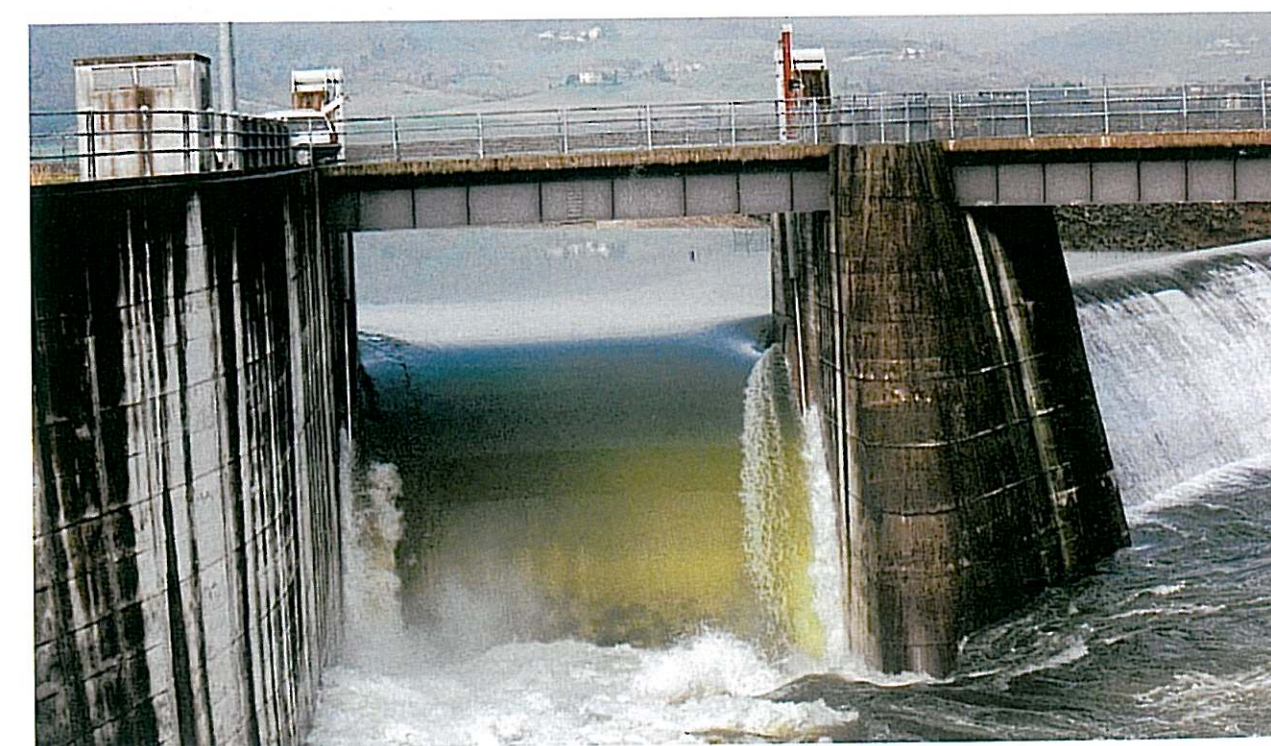
Foto n. 5 - Invaso di Bilancino - vista dello scarico di superficie
